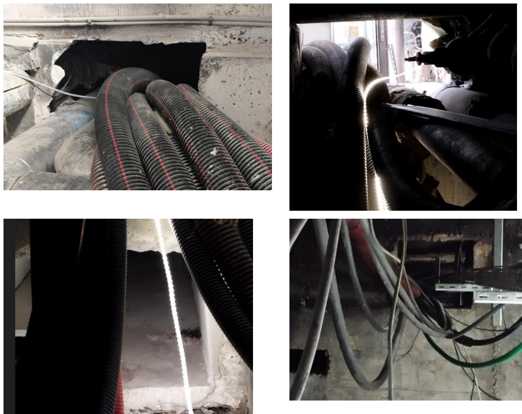
Figure 11. [Exemples de rebouchages à effectuer]
